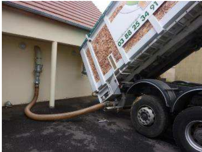
LE SILO INTERNE
