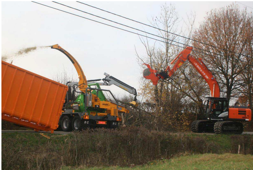
Figure 34 : Weekend du bois 2018 : Elagage de branches d'arbres le long d'une ligne électrique.
