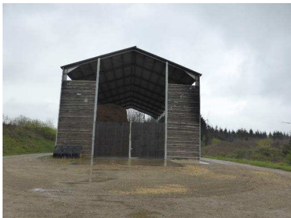
Figure 46 : Hall de séchage et de stockage pour les plaquettes de bois de la ville de Saint-Vith.
