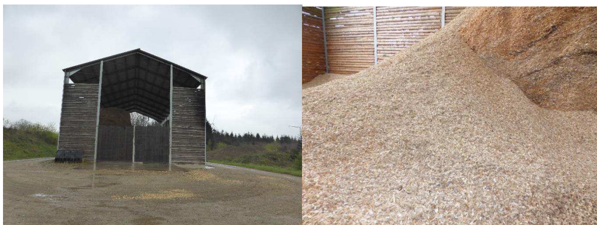
Figure 23 : Hall de stockage pour les plaquettes de bois de la ville de Saint-Vith
