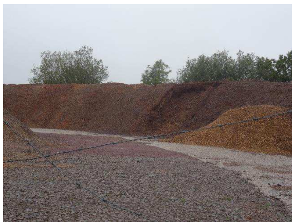
Figure 47 : Stockage de plaquettes de bois à l'air libre, sur une dalle bétonnée.
